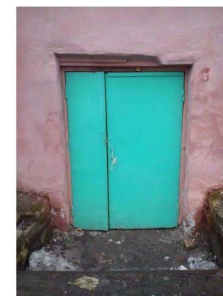
Фото 3. Вход в цокольный этаж
