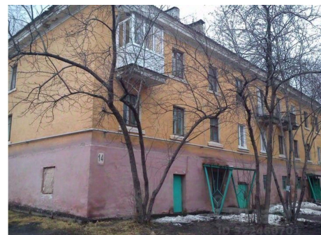
Фото 1. Внешний вид здания
